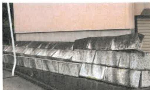
出典 (一財) 消防科学総合センター
