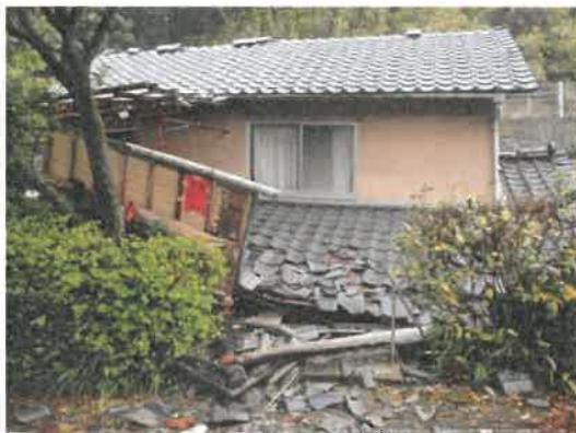
熊本地震の被災家屋（西原村）
