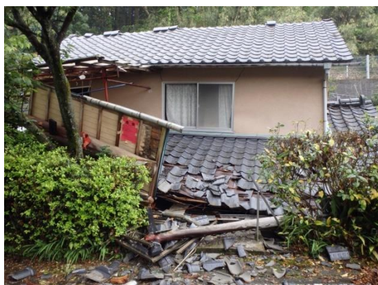
熊本地震の被災家屋（西原村）
