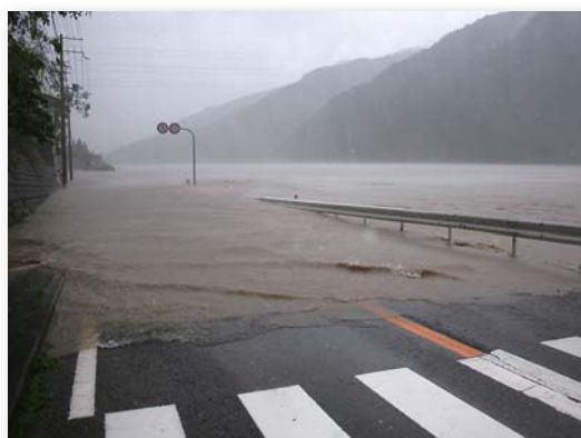
熊野川が増水し、冠水した国道168号
