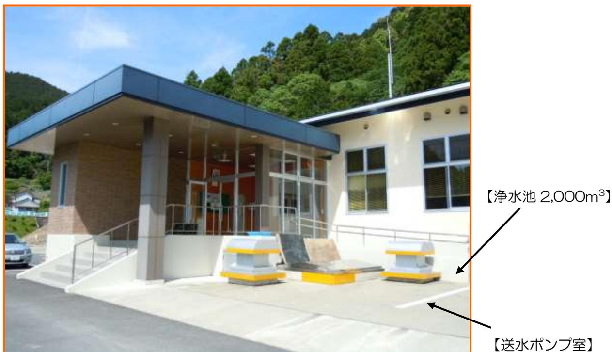
※管理棟の地下に浄水池 2,000m<sup>3</sup> 及び送水ポンプが設置されています。
