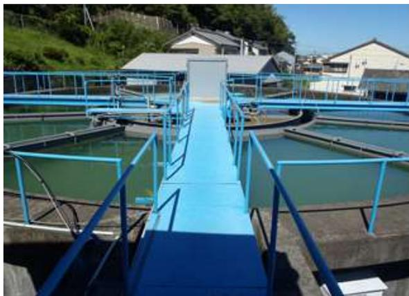
【高速凝集沈澱池（アクセレータ）】
