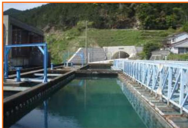
【横流式傾斜板沈澱池】
